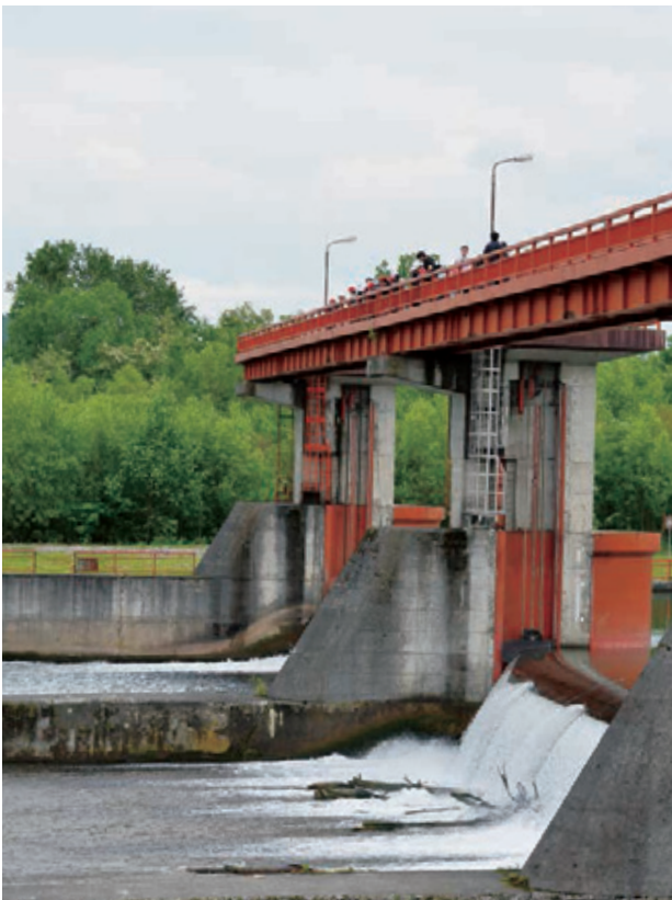
写真上／我々にとってかけがえのない水資源「石狩川」 写真下／石狩川から農業用水を取り入れる大雪頭首工
