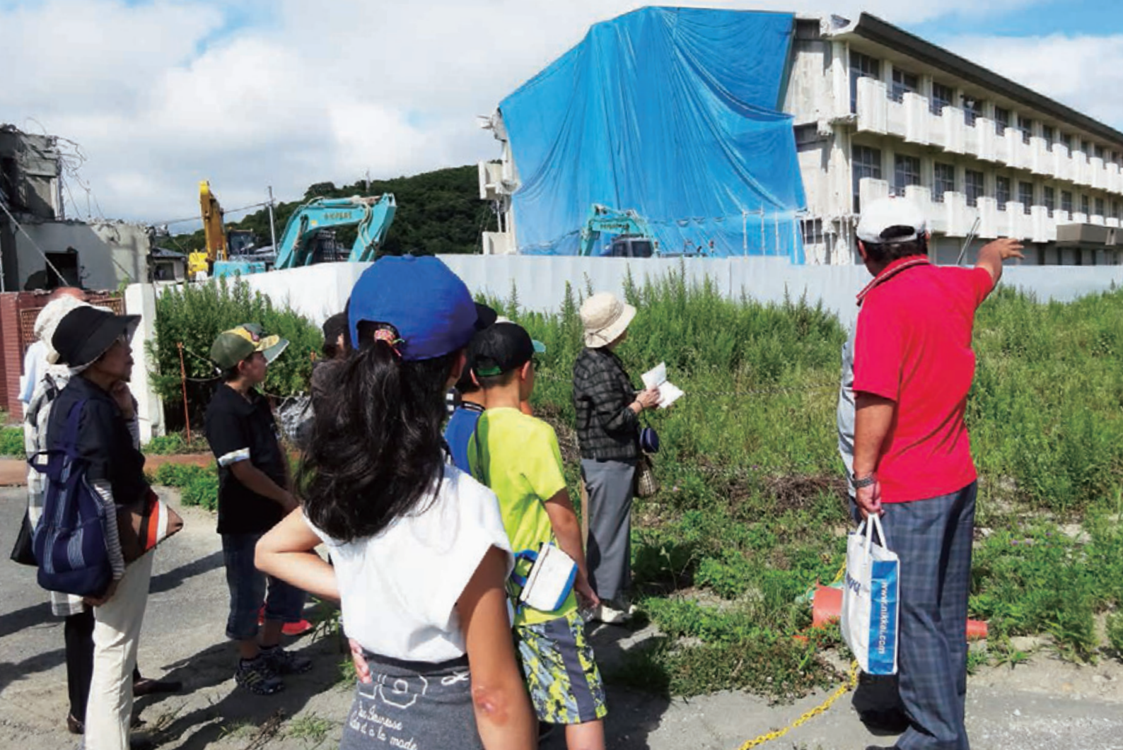
損壊が大きく、解体される湊第二小学校（平成28年度の交流事業より）
