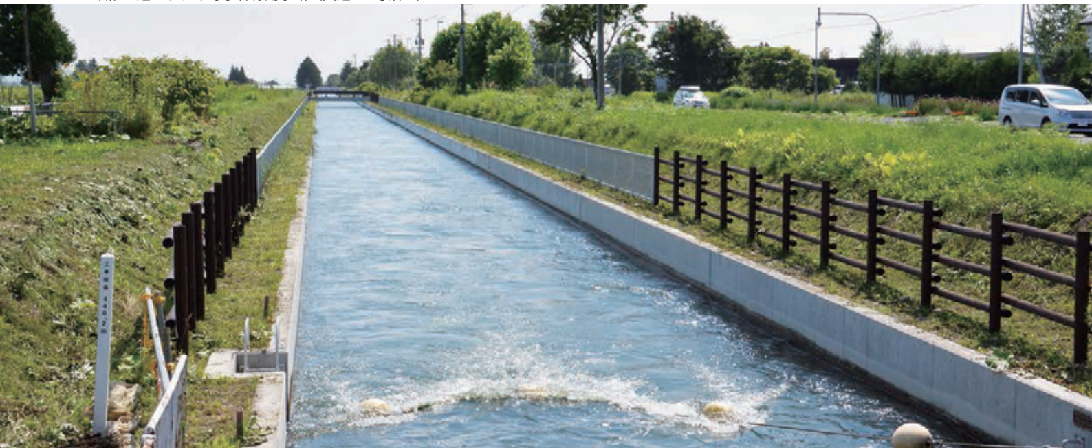
改修が進められる導水幹線用水路（国道39号沿い）
