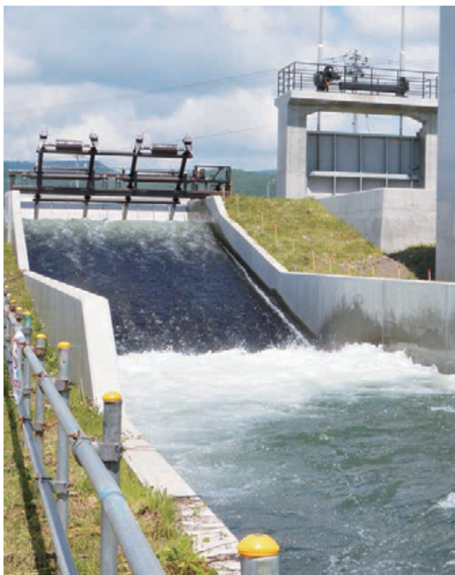
写真右／奥が水流をプロペラで回す「S型チューブラ水車」。手前にある発電機で電力を発生させる
