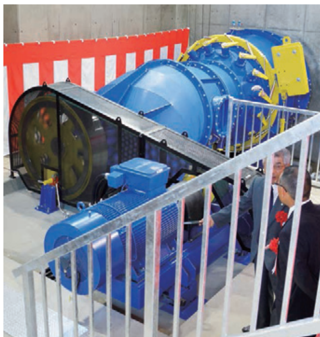
写真右／奥が水流をプロペラで回す「S型チューブラ水車」。手前にある発電機で電力を発生させる
