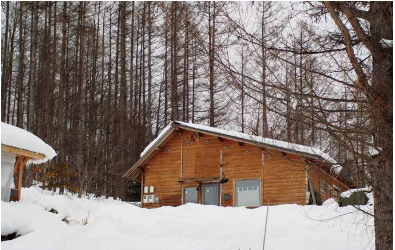
基礎工事から全て翼さんが手掛けた住宅。住宅前部には紗也子さんが腕を振るうパン屋「K i g i」がある(次ページ)
