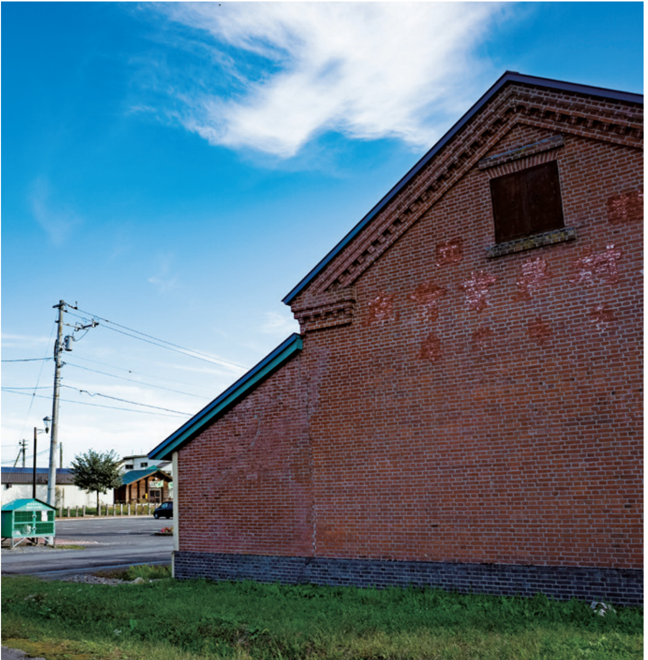
JR伊香牛駅前には2棟の倉庫が並んでいる。当時を物語る貴重な建物の一つとなっている
