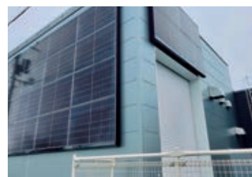
建設中の当麻郵便局舎壁面に設置される太陽光パネル
