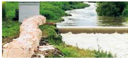
当麻川越水箇所を設置された大型土のう
