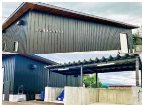
地域防災拠点施設の中核「防災備蓄品保管倉」
