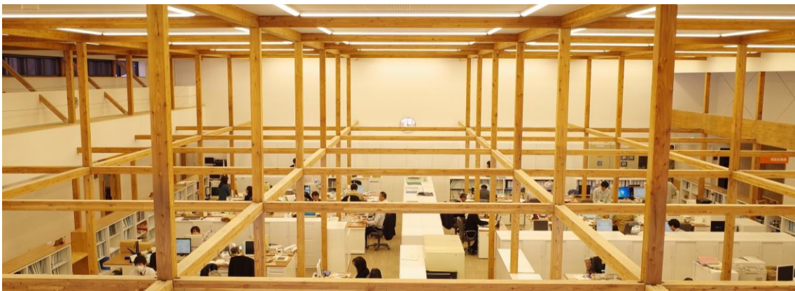
役場庁舎 H30.2 完成（1 期工事）
